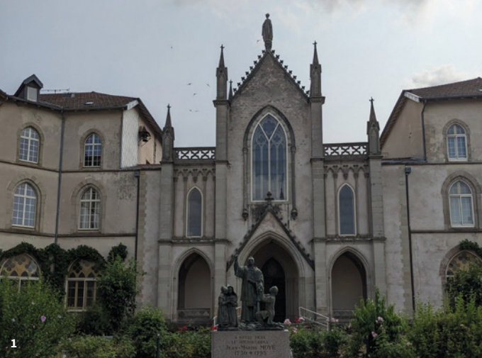
1. Façade de l'église du couvent des Sœurs de la Providence
